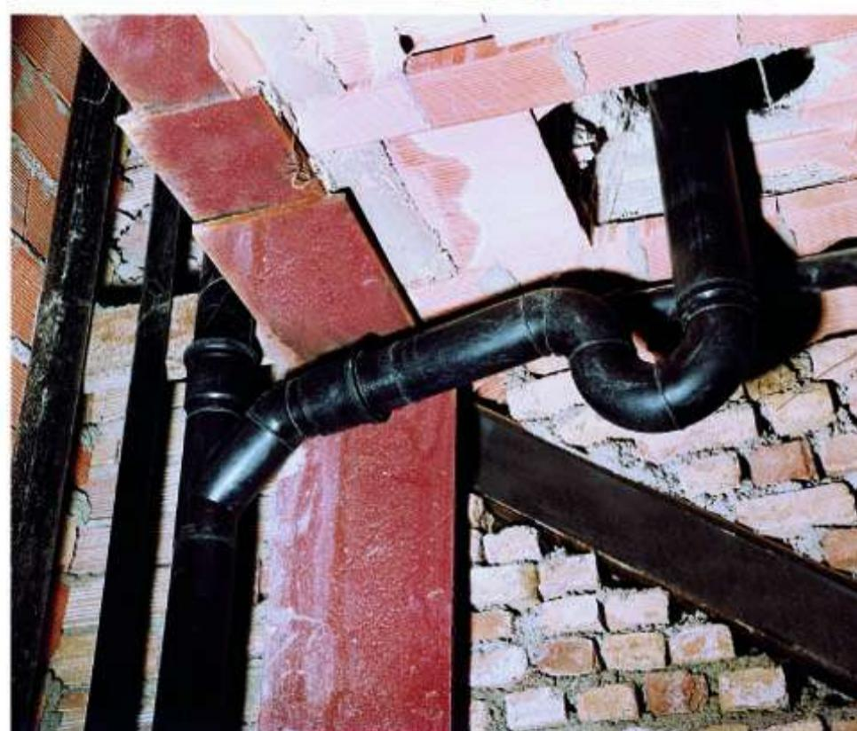
در هنگام نصب و اجرا شیب لازم را برای مسیرهای درنظر بگیرید و اتصالات و لوله هارا در مسیرهای افقی و عمودی با استفاده از بست های مناسب ثابت کنید. لطفاً در صورت استفاده از دستگاه جوش به نکات مورد توصیه کارخانه سازنده توجه فرمایید.
